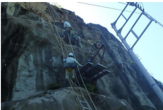
2.調査機の引き上げ
