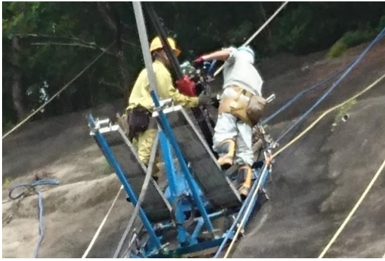
高所や凹凸のり面での調査
