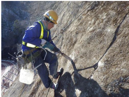
吹付体コア抜き
