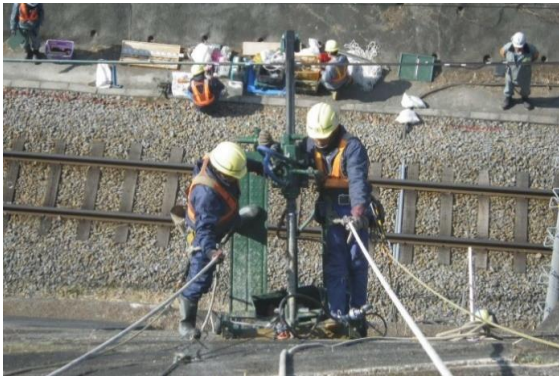
軌道上での調査(電車運行時中断しやすい)
