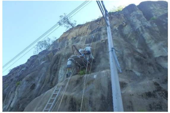
ロープ足場で調査(傾斜地足場不要)
