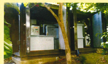
K-2000 地上設置型水質浄化装置。浄化用ヤクルトろ材が入っています。
