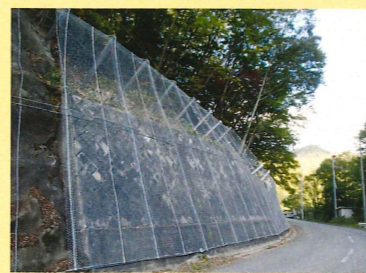
ロックネット工 山の上から落ちてくる石を受け止め下部に誘導します。
