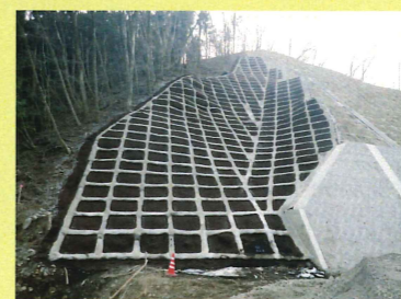
簡易法砕工 法面表層の崩落を防ぐ低コストな法砕工です。
