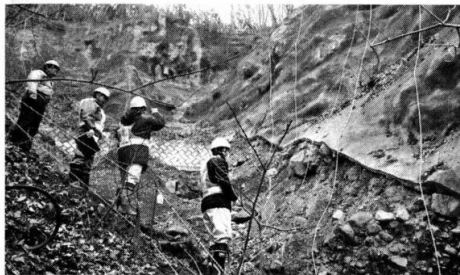
点検項目に沿って施工現場をチェック(沼田市利根町)
