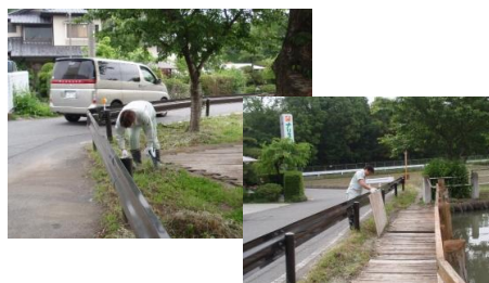
〈本社〉ゴミ拾い、草刈り、橋の仮補修
