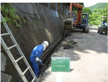
〈藤原 ii -①〉道路清掃(U字溝)
