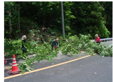
〈藤原 i〉支障木の伐採
