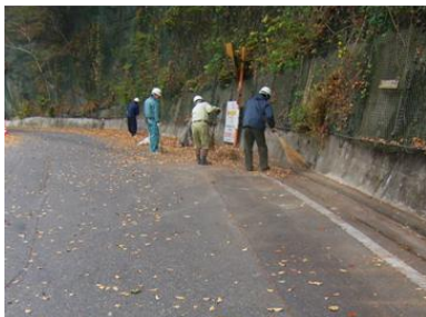
現場周辺の道路清掃をしました。 〈渋川市赤城町〉
