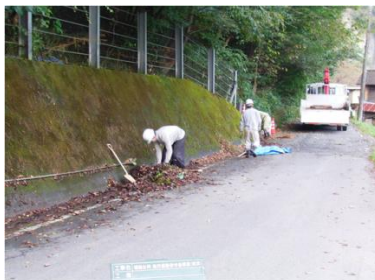
現場周辺県道の落葉掃除をしました。 〈渋川市赤城町〉
