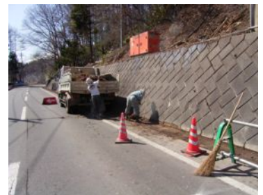
工事現場周辺道路の清掃。 〈孺恋村大字三原〉
