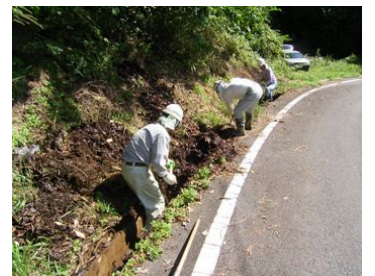
道路の側溝清掃〈吾妻郡長野原町林〉
