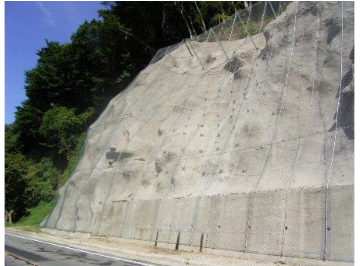
利根郡みなかみ町下牧(主)沼田水上線
