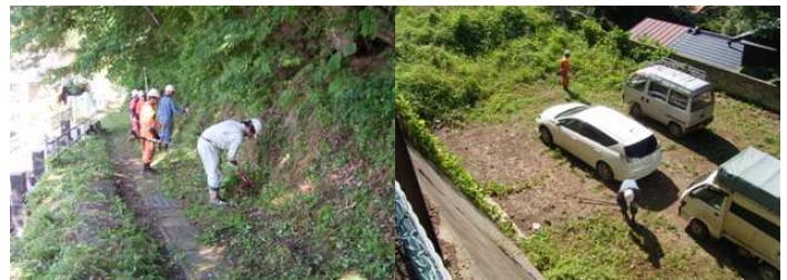
現場入口、作業道、駐車場の草刈りをしました。〈遠西現場〉
